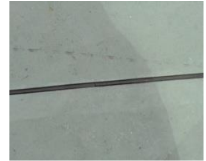
Magnetic Bar 삽입 (폭 6mm, 깊이 10mm)
