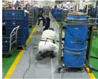
컷팅작업 (콘크리트 컷팅, 건식)
